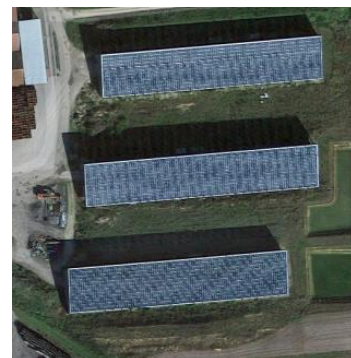
Toiture PV agricole à Brouchy 2
